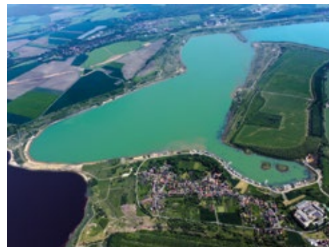
Hainer See, 2015 Unterwasserrodung auf dem Störmthaler See, 2013 Stationäre Neutralisationsanlage am Zwenkauer See, 2012
